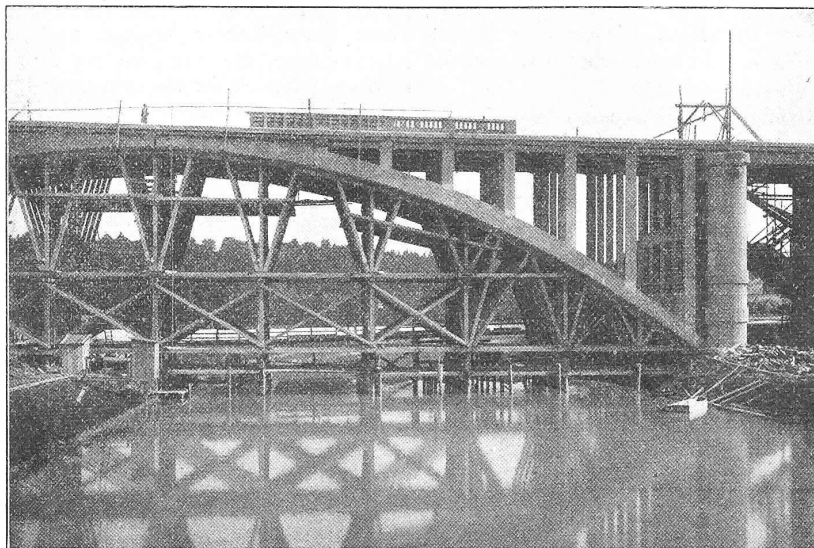
Abb. 12. Ansicht der linksufrigen Flussöffnung vor der Ausrüstung.
