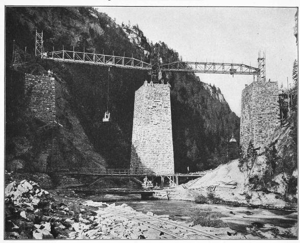
Abb. 14. Der Landwasserviadukt. — Aufführung der grossen Mittelpfeiler.
