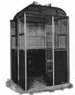
Druckknopf – Seilsteuerung, sicherst wirkende Fangvorrichtung, geräuschloser Gang, automatische Schachtsicherungen.
