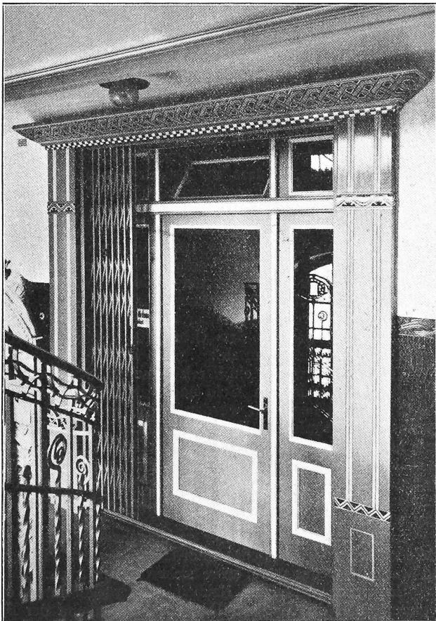
Abb. 10. Stockwerksabschluss mit Postwickgitter.
