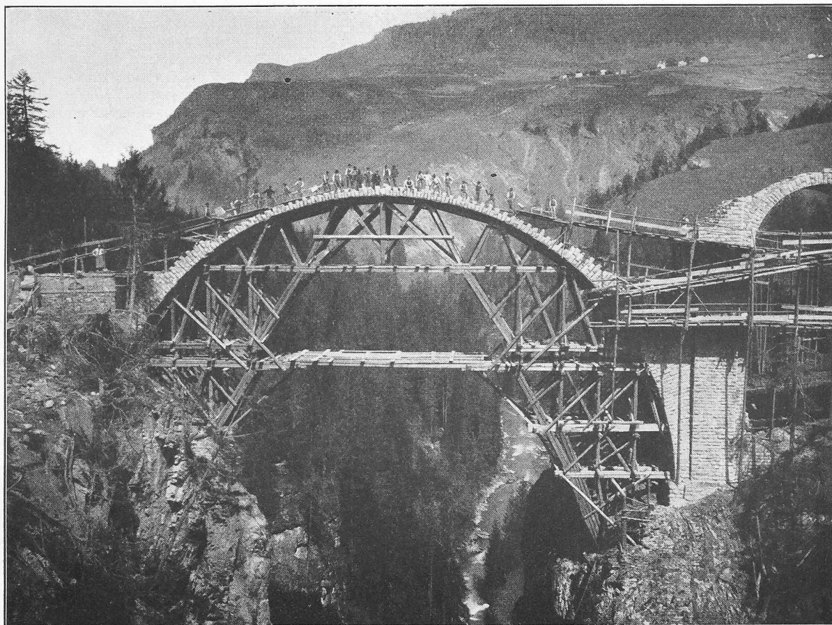
Abb. 6. Lehrgerüst der Hauptöffnung der Solisbrücke bei Schliessung des ersten Gewölberinges.
