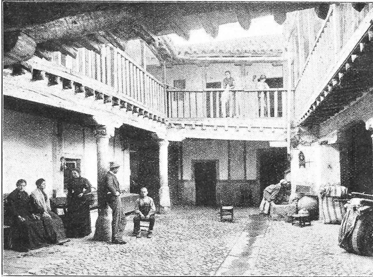
Abb. 3. Hofraum (Patio) eines Zweifamilienhauses in Toledo.
