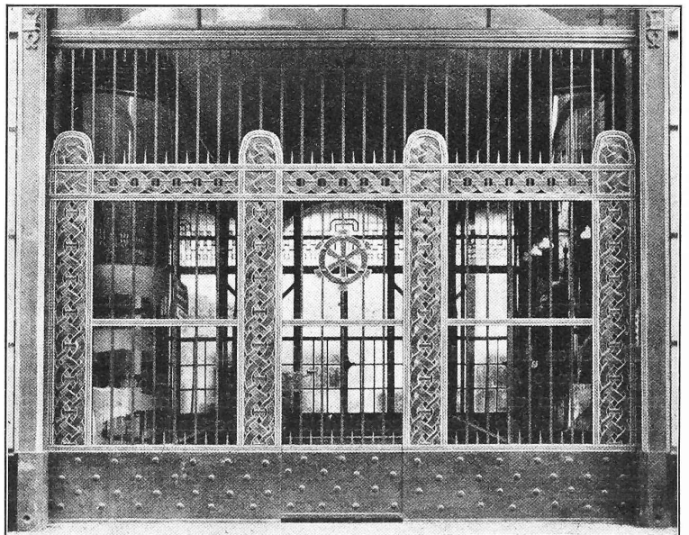
Abb. 8. Versenkbares Abschlussgitter des Haupteinganges.
