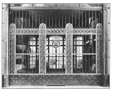
Abb. 8. Versenkbares Abschlussgitter des Haupteinganges.
