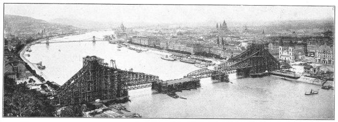
Abb. 4. Aufstellung der Gerüstbrücken für den Bau der Elisabeth-Brücke mit Schwimmgerüst in einer mittlern Schiffahrtsöffnung.
