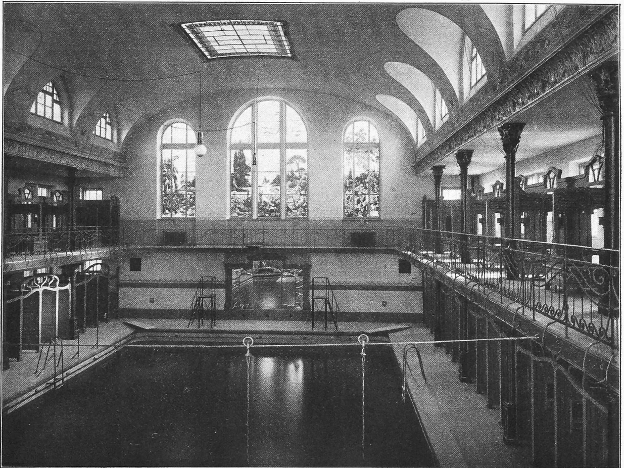
Abb. 11. Blick in die Männerschwimmhalle gegen Osten.
