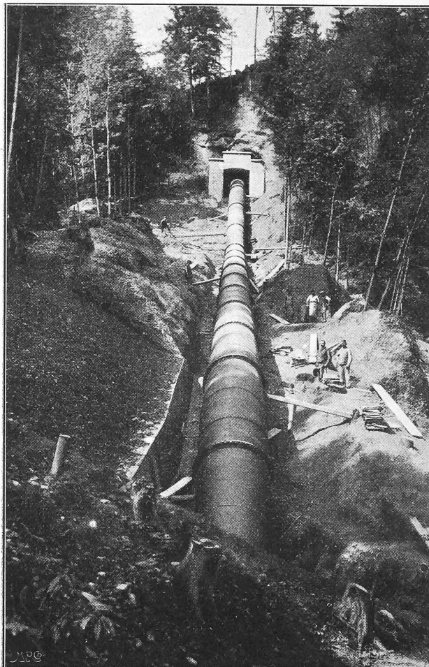
Abb. 30. Mittlerer Teil der Druckleitung.
