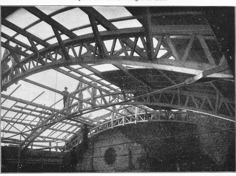
Abb. 1. Deckenkonstruktion für die Reithalle der Gebr. Keller in Basel.
