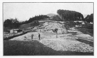
Abb. 25. Reinigung des Untergrundes für den nördlichen Abschlussdamm.
