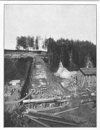
Abb. 19. Fundamentaushub für die östliche Staumauer.
