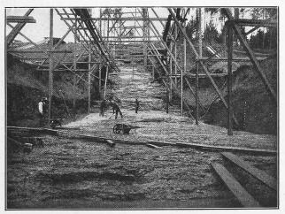
Abb. 20. Reinigung der Fundamentsohle für die östliche Staumauer.
