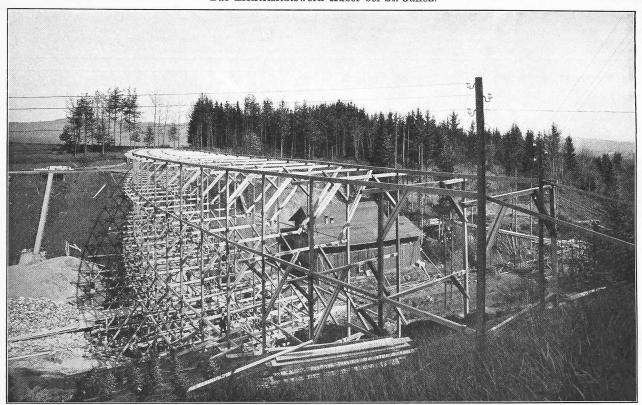
Abb. 21. Die Gerüstung zur Herstellung der östlichen Staumauer.
