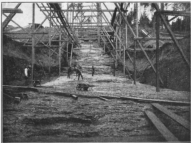
Abb. 20. Reinigung der Fundamentsohle für die östliche Staumauer.
