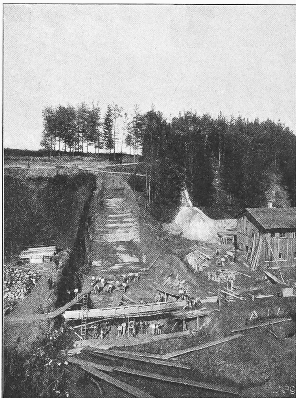
Abb. 19. Fundamentaushub für die östliche Staumauer.
