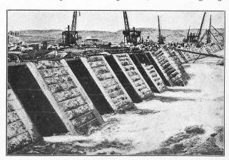
Abb. 17. Die untere (nördliche) Seite des Assuan-Staudammes im Bau.
