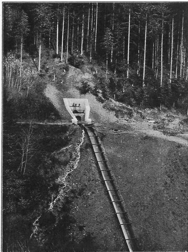
Abb. 9. Leer- und Ueberlauf aus dem Stollen «im Halden».
