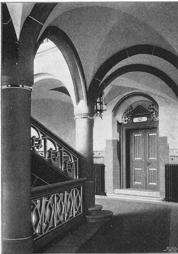
Abb. 7. Treppenaufgang im I. Stock.
