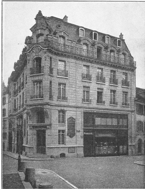
Fig. 17. Maison Wolfrath, rue du Temple Neuf à Neuchâtel.
