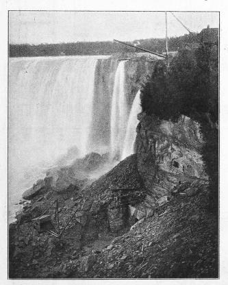
Abb. 6. Ausmündung des Ablaufstollens für die Anlage der Canadian Niagara Falls Power Co. am Hufeisenfall.
