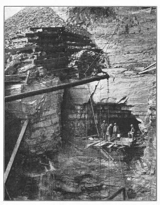
Abb. 7. Mündung des Ablaufstollens im Bau.
