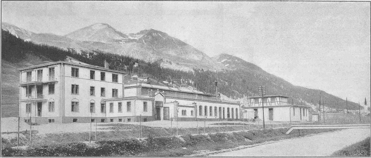
Abb. 2. Gesamtansicht der Anlage von Südosten.
