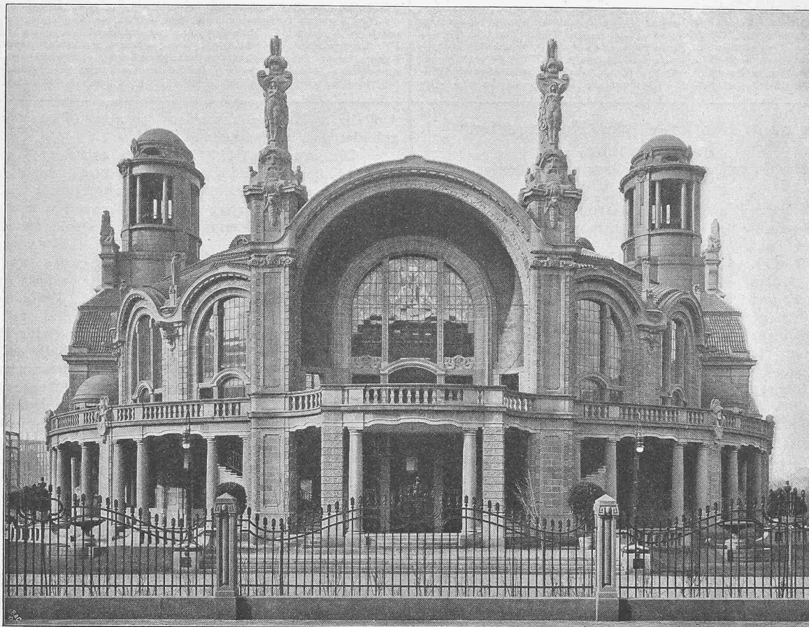
Abb. 2. Ansicht der Südseite der neuen Festhalle in Mannheim.
