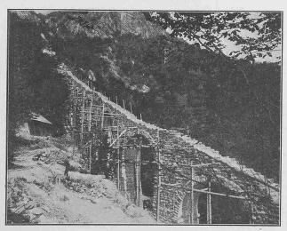
Abb. 11. Viadukt von 100 m Länge im Bau.
