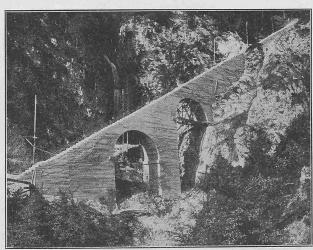
Abb. 9. Viadukt von 25 m Länge im Bau.
