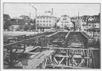
Abb. 8. Montierung des eisernen Oberbaues.
