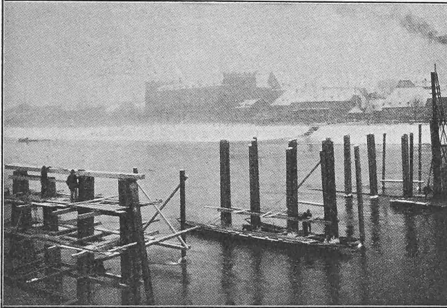
Abb. 10. Die hölzernen Brückenjoche im Bau.
