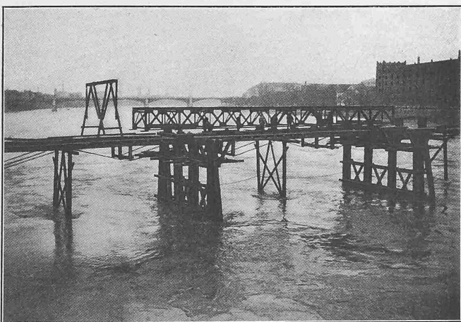
Abb. 9. Aufstellung eines Parallelträgers.
