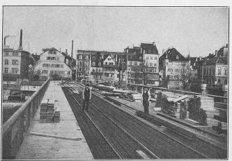
Abb. 3. Herstellung des Brückenbelages.
