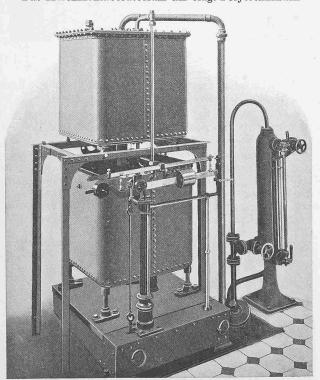
Abb. 20. Dampfkondensat-Messvorrichtung.
