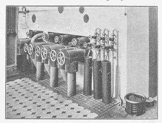
Abb. 19. Mantelwannen, Auffanggefässe und Verzweigung der Dampfleitungen.
