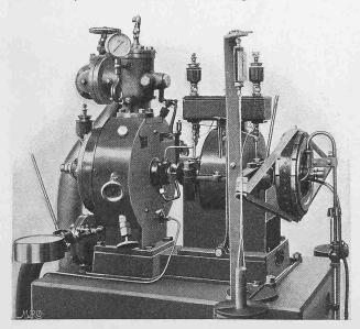
Abb. 17. 10 P. S .- de Laval-Dampfturbine.
