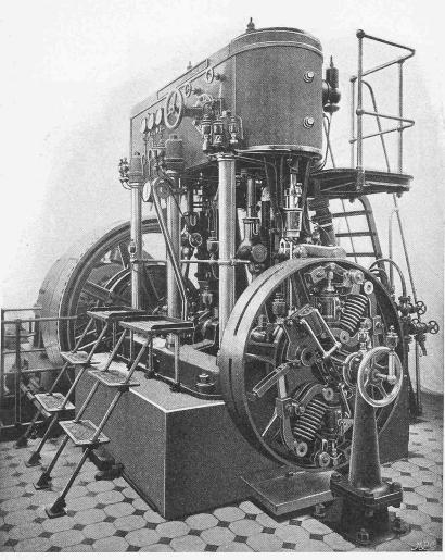
Abb. 12. Vertikale Verbundmaschine, gebaut von Escher Wyss & Cie. in Zürich.
