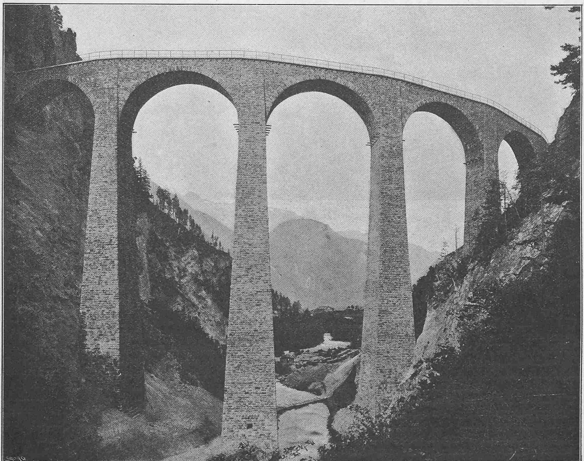
Der Landwasser-Viadukt mit sechs Öffnungen zu 20 m.
