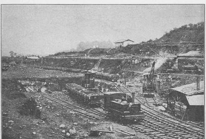
Abb. 31. Fundamentaushub für die Schleuse bei Cuatro-Calle.
