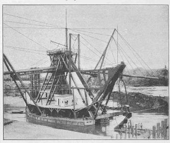
Abb. 24. Grosse amerikanische Baggermaschine mit langer Förderrinne.
