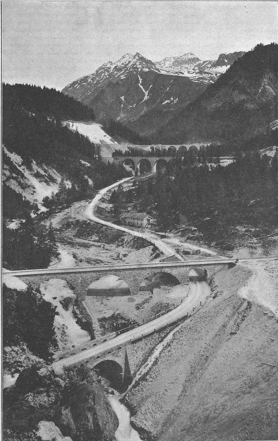
Albulabahn. — Entwicklung unterhalb Preda. — Viadukt I, II und III.
