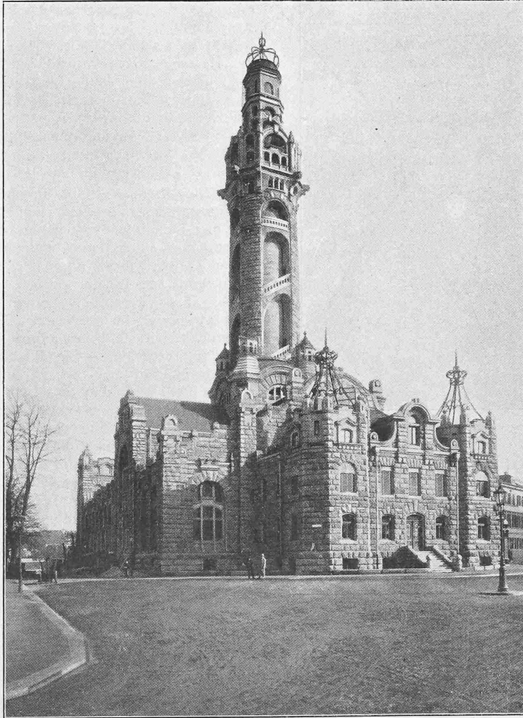
Fig. 2. Die Zentrale des Fernheiz- und Elektrizitätswerkes in Dresden.
