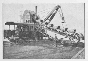
Abb. 18. Tiefbagger, Typ Culebra.
