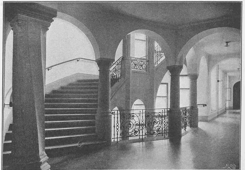
Abb. 16. Treppenhaus im Westflügel.
