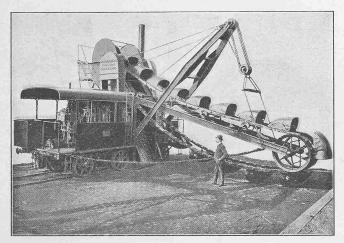
Abb. 18. Tiefbagger, Typ Culebra.
