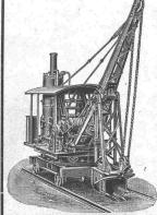
zum Abgraben von Erdmassen und Verladen derselben in Wagen, auch als Krahn zum Heben von Lasten und als Greifbagger verwendbar.
