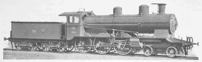
Abb. 6. Die Vierzylinder-Verbundlokomotive der Jura-Simplon-Bahn. Gebaut von der *Schweizerischen Lokomotiv- & Maschinenfabrik* in Winterthur.
