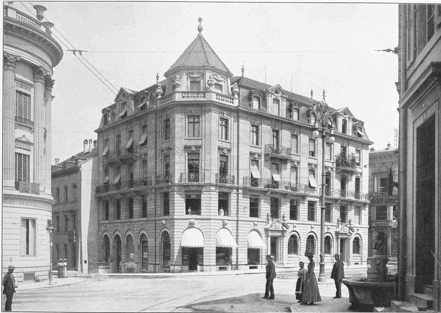
Die Freie Strasse in Basel. — Der Neubau der Handwerkerbank Basel.
