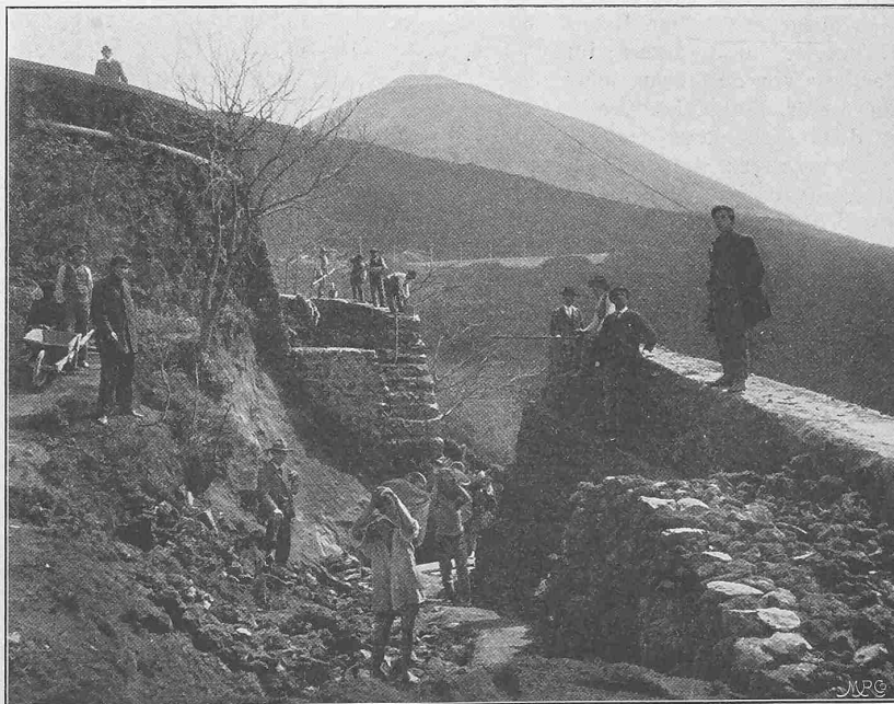
Abb. 23. Bau der Stützmauer der Vesuvbahn unterhalb der Terasse des Observatoriums.
