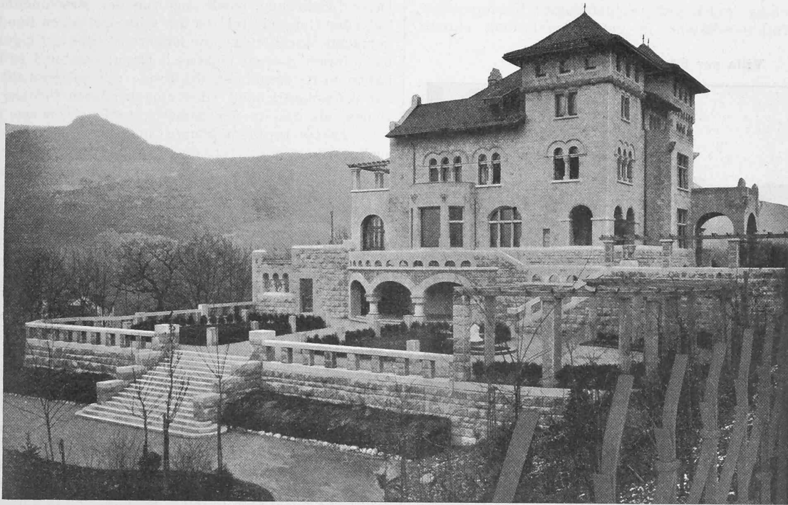
Abb. 4. Ansicht von Westen.
