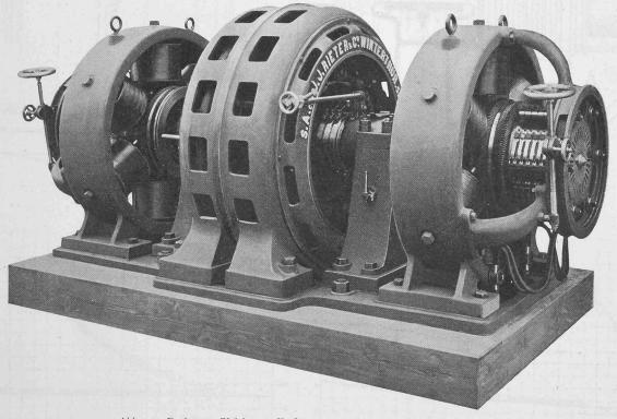
Abb. 1. Drehstrom-Gleichstrom-Umformergruppe von 150 P. S. - Ansicht,
