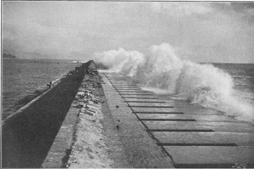
Abb. 13. Brandung an dem bei der Durchbruchstelle verstärkten Molo Galliera.
