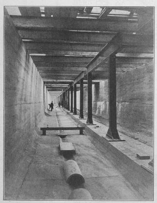
Abb. 28. Unterpflasterbahn im Bau.
