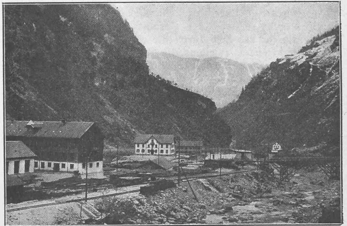
Abb. 55. Südseite. — Unterer Teil des Installationsplatzes.
