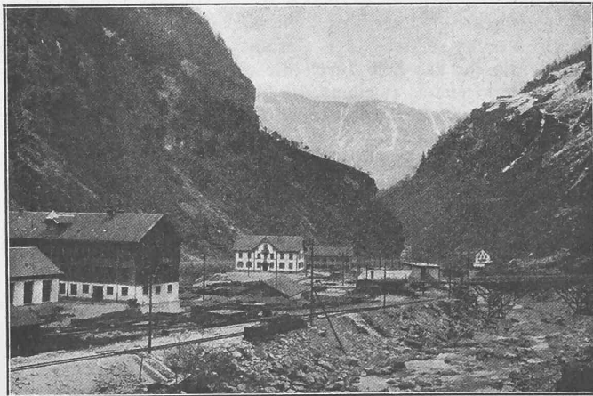
Abb. 55. Südseite. — Unterer Teil des Installationsplatzes.
