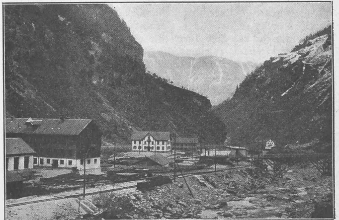
Abb. 55. Südseite. — Unterer Teil des Installationsplatzes.
