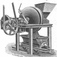
Für Bauunternehmer als Beton- und Mörtelmaschine.
