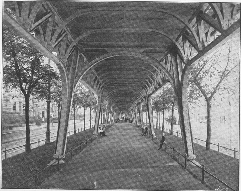
Abb. 11. Der Viadukt in der Bülowstrasse.
