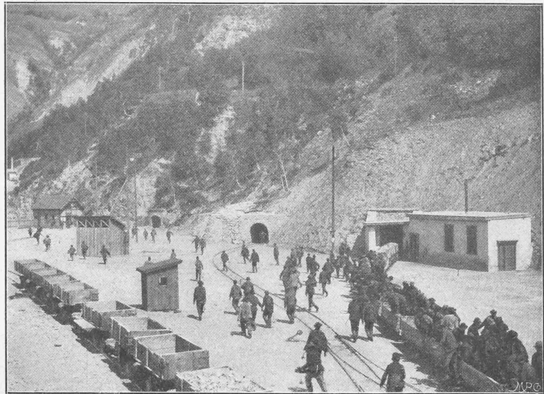
Abb. 46. Mündungen von Richtstollen, Tunnel I und Tunnel II (Nordseite) mit Arbeiterzug aus Tunnel II kommend. (Sommer 1900.)
