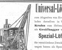
zum Abgraben von Erdmassen und Verladen derselben in Wagen, auch als Krahn zum Heben von Lasten und als Greifbagger verwendbar.
