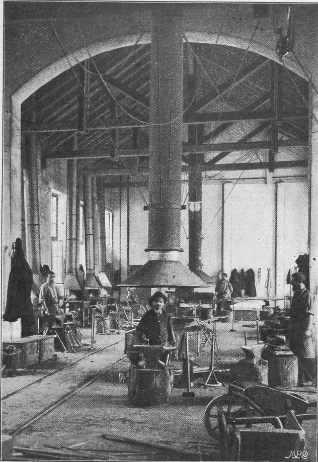
Abb. 69. Die Schmiede auf der Nordseite.
