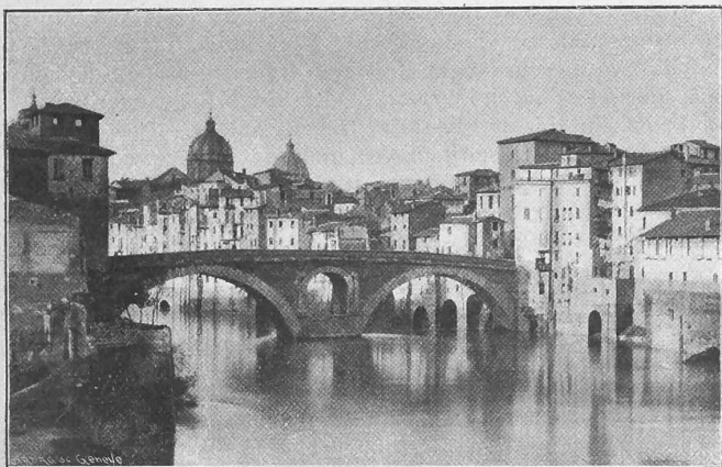
Fig. 1. Der Ponte Fabricio. — Vor der Tiberregulierung.
