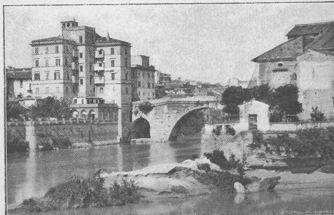
Fig. 2. Der Ponte Cestio. — Vor der Tiberregulierung.
