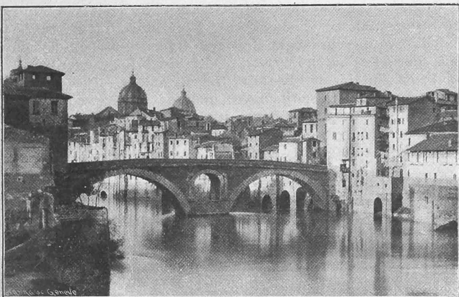
Fig. 1. Der Ponte Fabricio. — Vor der Tiberregulierung.
