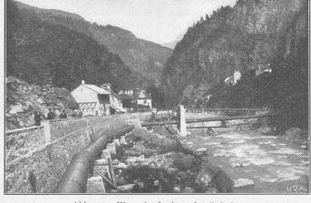
Abb. 31. Wasserkraftanlage der Südseite. Ueberführung der Druckleitung über die Diveria, oberhalb Iselle.
